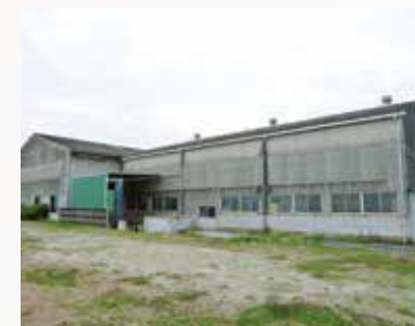
第2工場 製缶・溶接
