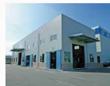
第4工場 機械加工
