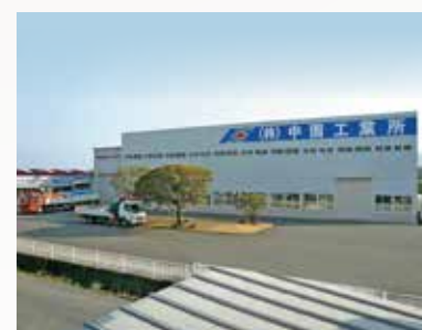
第4工場 検査・組立・配管溶接
