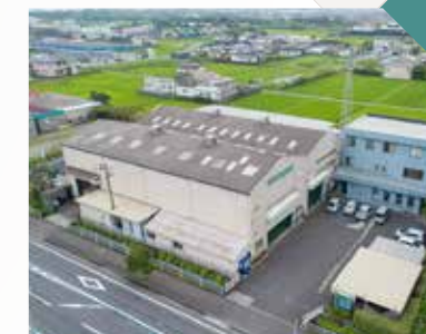
第3工場 機械加工・本社事務所
