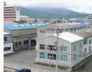
第1工場 機械加工
